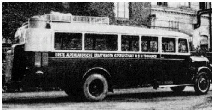
**Рис. 8.** Типичный газовый фургон, первоначально – обычный автобус, впоследствии оснащённый газогенератором и двигателем фирмы Заурер[82].
