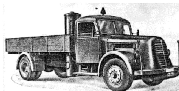
**Рис. 10.** Стандартный газогенераторный грузовик Austro-Fiat 4 D 90 A[85].
