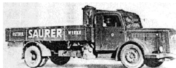
**Рис. 9.** Автомобиль Заурер BT 4500 с газогенератором[85].
